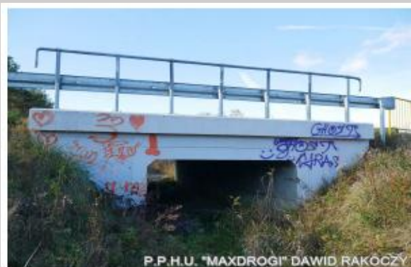
Rysunek 6 Przepust drogowy w ciągu drogi nr 377033T, miejscowość Szewce
